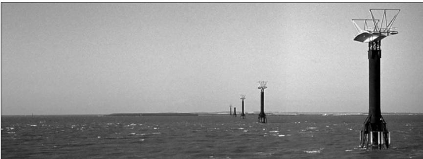
Die Pylone für die Seilbahn, mit der große Teile des Oosterschelddamms aufgeschüttet wurden (1976) ...
